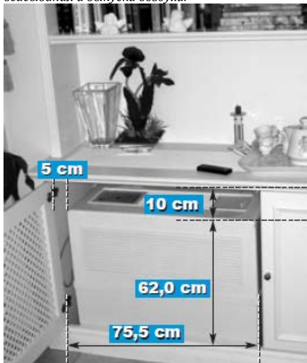
Установка увлажнителя воздуха в жилой комнате
